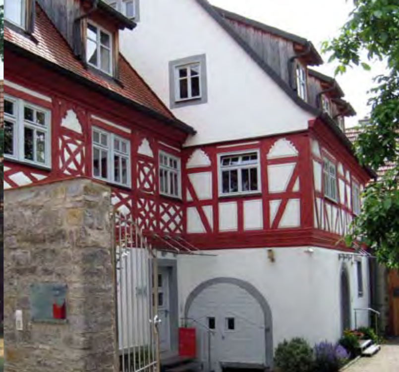
Nach den Renovierungs- und Restaurierungsarbeiten ist ein modernes Weingut entstanden: „Best practise“ im wahrsten Sinne des Wortes.
