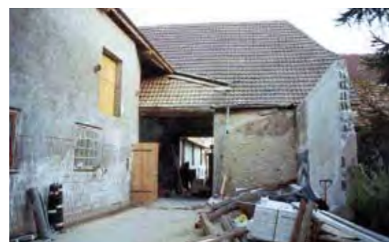
Beim Umbau einer Scheune in Kolitzheim konnte die alte Baustruktur im Ortskern weitgehend erhalten bleiben.
