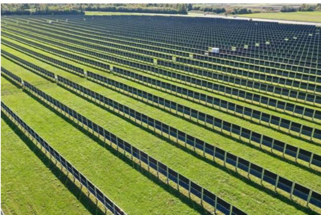
▣ Bild 1: Vertikal aufgeständerte Agri-PV-Anlage (Foto: Johannes Scharf)
