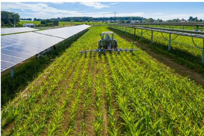
Bild 3: Agri-PV-Anlage mit nachgeführten Modultischen (Foto: Thomas Rebitzer)
