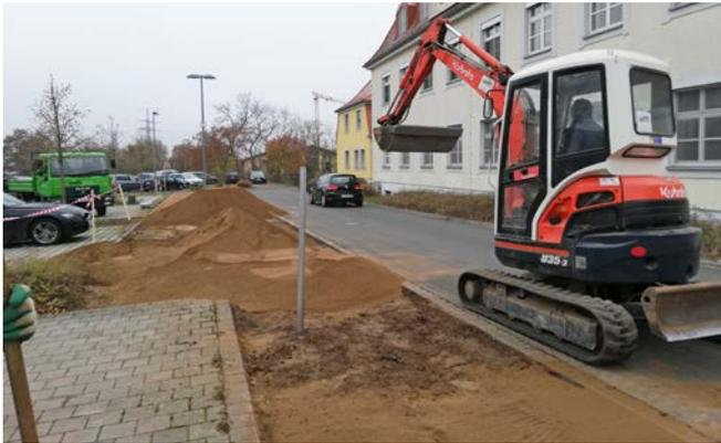
Bild 1: Rodung, Bodenaustausch und Auffüllung mit magerem Oberboden (Fotos: Maria Lutz)
