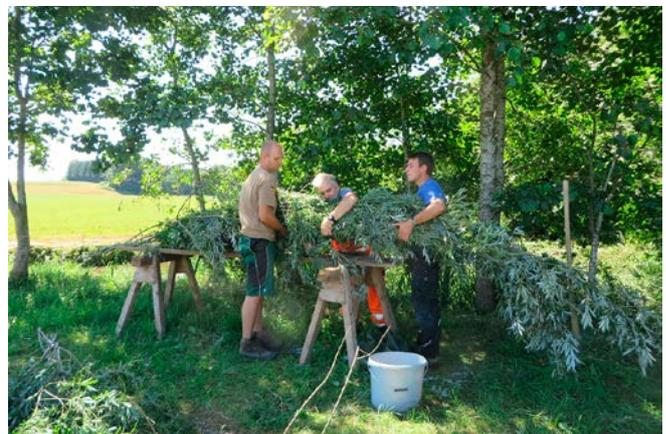
Bild 2: Das Anfertigen von Faschinen zur Verfestigung des Dammes
