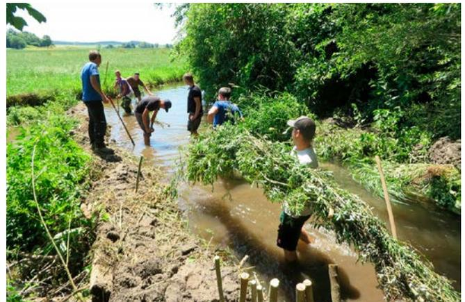
▭ Bild 4: Das Einbringen der Faschinen am Damm zur Wasserumleitung
